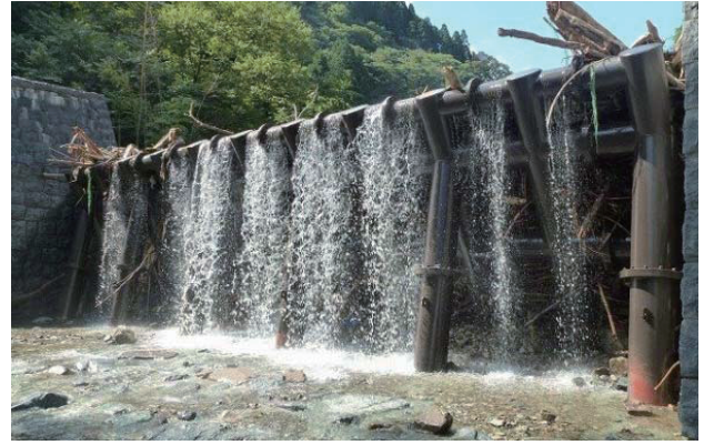
写真9 土石流を捕捉したJ-スリット堰堤(ジェイスリットえん堤 ® )
