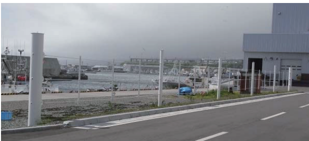
写真 11 津波バリアー
