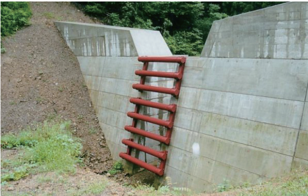
写真4 鋼製スリットビーム Photo 4 Steel slit dam (Beam type)
