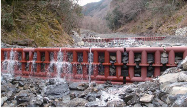
写真 10 鋼管枠工
