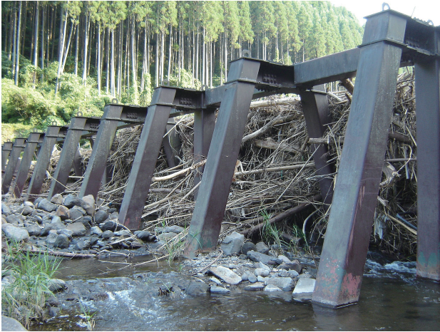
写真3 流木を捕捉したD型スリット堰堤 Photo 3 Steel slit dam (D-Type) which caught floodwood
